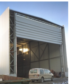
Offshoreport til helikopterhangarer i Nordsjøen. Offshoreporter leveres standard for vindlast på min. 3000N/m 2
