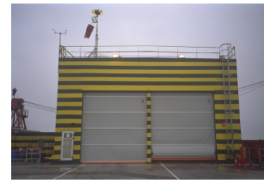
Offshoreport til helikopterhangarer i Nordsjøen. Offshoreporter leveres standard for vindlast på min. 3000N/m 2
